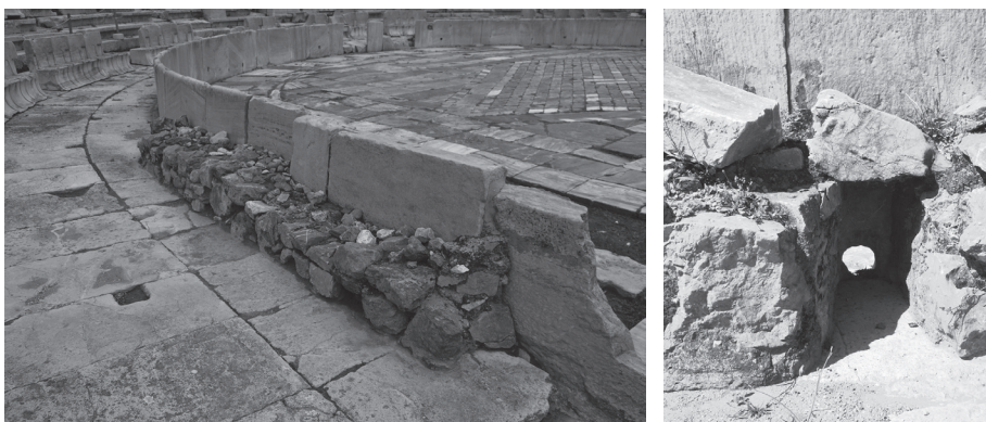
Εικ. 13. Τοιχάριο που εφάπτεται στην εσωτερική πλευρά του θωρακίου με άνοιγμα για τη διοχέτευση του νερού (φωτ. M. Vitti).
