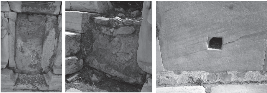
Εικ. 11. Επένδυση με υδραυλικό κονίαμα στις πλάκες του θωρακίου και στο Βήμα του Φαίδρου (φωτ. M. Vitti).
